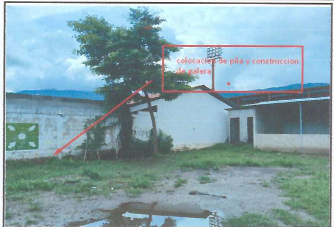
Foto 2: COLOCACION DE PILA EN LA PARTE DE ATRÁS DE LA ESCUELA
