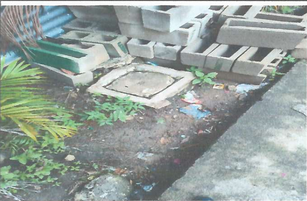
Foto 3: REPARACION DE RED A DE DRENAJES Y AGUA POTABLE
